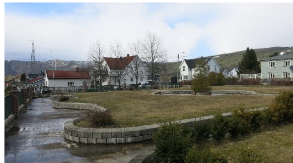
Foto 12. Over parkeringsanlegget er det etablert park. Det siver vann fra beplantede områder ut til gangstiene.
