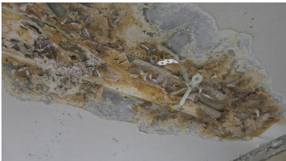
Foto 5. Kraftige fuktmerker enkelte steder under betongdekke.
