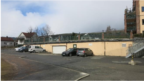
Foto 9. Parkeringsanlegget med yttervegg delvis under terreng på to sider.
