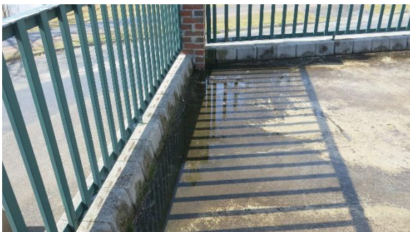
Foto 13. Vann blir ledet ut mot takrenne på yttervegg gjennom en ringmur av betongblokker.
