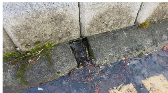
Foto 14. Skåret spor i betongblokker som er stedvis tettet med løv og nedfall.
