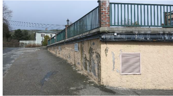
Foto 10. Yttervegg delvis under terreng har stedvis store fuktskader.
