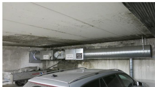
Foto 8. Parkeringsanlegget er ventilert med avtrekksvifter med tilluft via ventiler i yttervegg.
