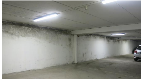
Foto 2. Synlig muggsoppvekst på øvre del av yttervegger.
