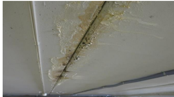
Foto 4. Stedvis fuktmerker og saltutslag på undersiden av betongdekke, hovedsakelig i skjøter mellom elementene.
