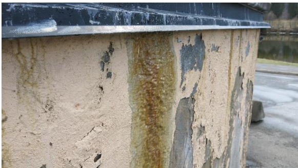
Foto 11. Vann fra overliggende parkanlegg renner stedvis bak overgangsbeslag.
